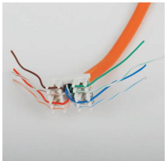
3. Introduire les fils dans les interstices du couvercle du connecteur selon le code couleur de la convention de câblage A ou B (voir paragraphe suivant).
